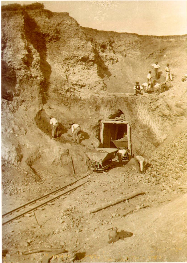
Construcción de uno de los túneles del ferrocarril Jerez-Almargen en 1929
