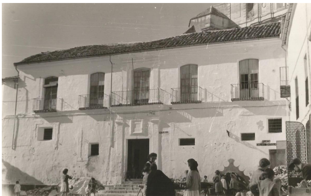
Demolición del edificio de la cárcel en 1958, ya sin puestos exteriores Foto: Juan Manuel Caballero de las Olivas y Buzón
