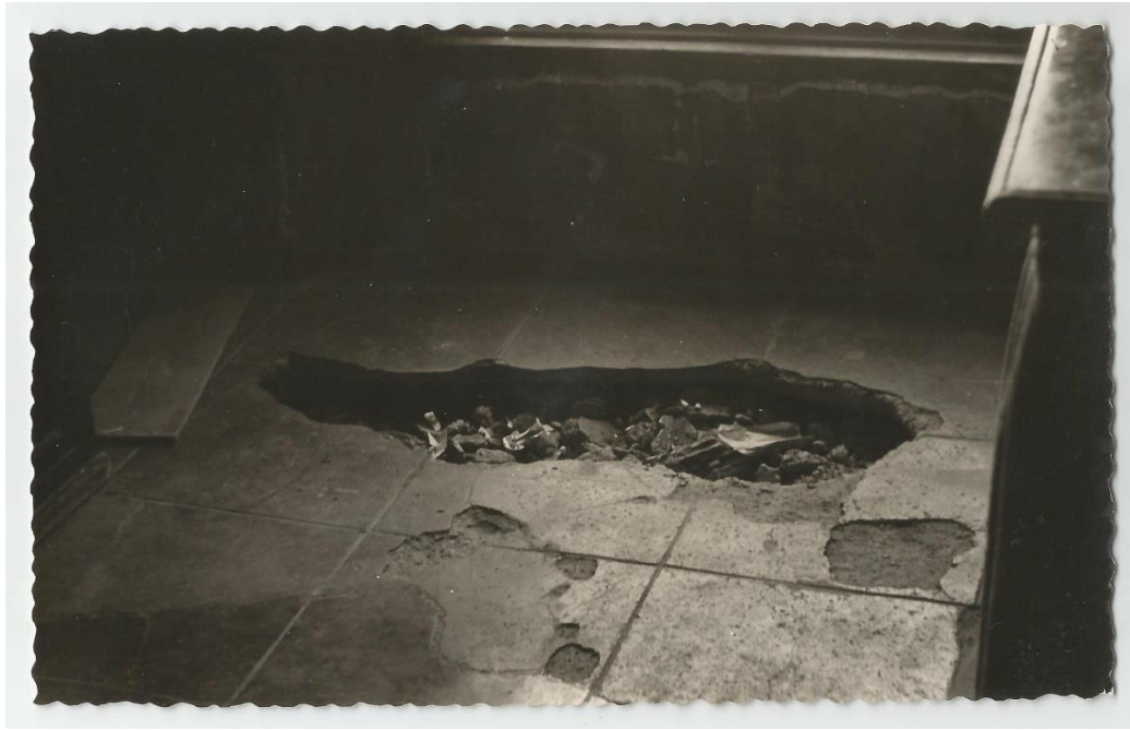
Solería de una oficina del Ayuntamiento en 1958 Foto: Juan Manuel Caballero de las Olivas y Buzón
