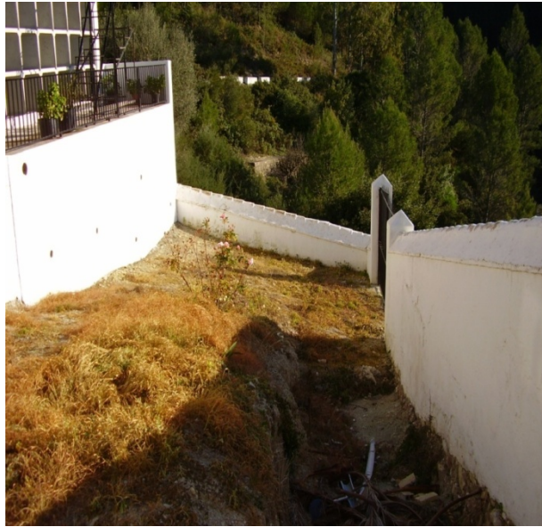
Esquina Suroeste del cementerio de El Bosque. Junto a esas tapias se exhumaron cinco fosas con víctimas de la represión franquista entre 2004 y 2005. Esta zona fue alterada con la construcción de bloques de nichos.
