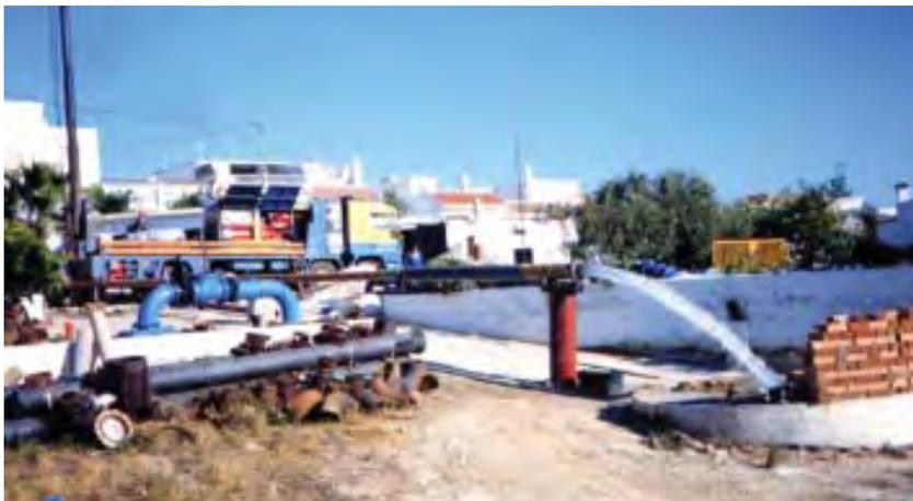
Ensayo de bombeo en la batería de sondeos de Arroyo de La Miel (Benalmádena) (parada 4)
